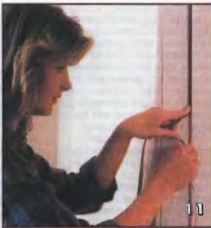
К фальцу дверной коробки приклеивают уплотняющий профиль
