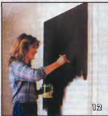
Обшивку двери, а также всей перегородки грунтуют, а затем оклеивают обоями, окрашивают или покрывают лаком
