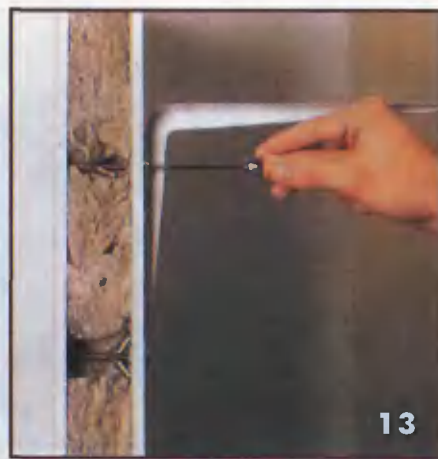
Кронштейны-полкодержатели крепят к перегородке на специальных, предназначенных для пустотелых конструкций, дюбелях
