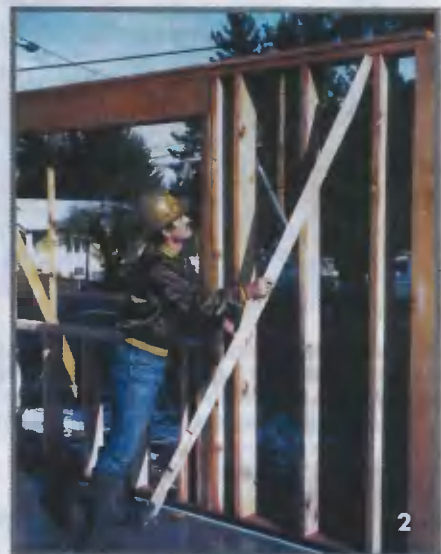
С помощью отжимной доски. Доску без сучков сечением 50х200 мм и длиной 3 м используют только для небольших перемещений выправляемой стены, но не для удержания ее в нужном положении. Металлическая накладка, прибитая к нижнему концу доски, удерживает ее от проскальзывания
