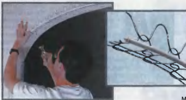
Проволочную защитную наклейку прибивают так же, как и металлическую
