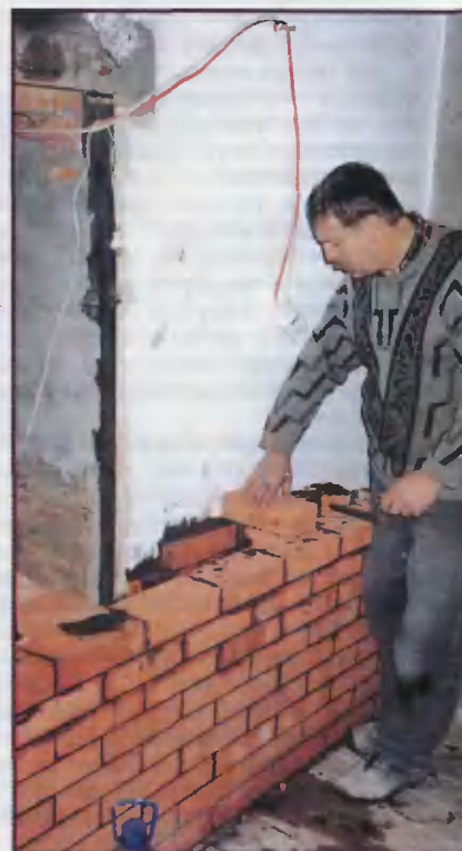
Кладка отопительного щитка — из обычного строительного кирпича
