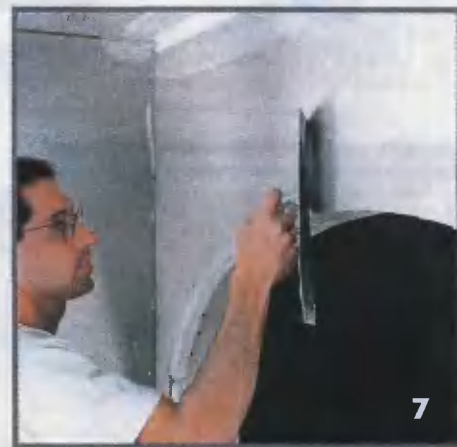
Отделка. После заклеивания лентой стыков поверхность проема тщательно шпаклюют
