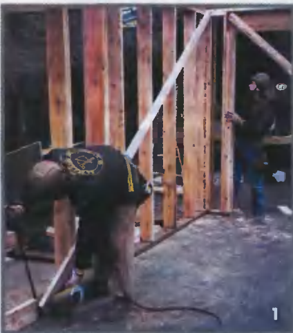
С помощью лома. Пока один работник передвигает стену, другой контролирует работу. Досылаемая ломом укосина перемещает верхнюю часть стены до нужного положения. Когда стена встанет вертикально, укосину прибивают к балке нижней обвязки
