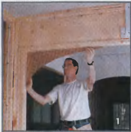
Начните разметку с картонного шаблона. Убедитесь в том, что конфигурация арки вас устроит, и перенесите разметку на проем
