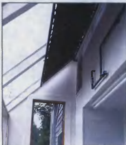
Солнечный коллектор над оранжереей работает параллельно с нагревателем воды в дровяной печке. Дрова и солнце — идеально дополняющие друг друга источники тепла. Когда нет солнца — разжигают печку
