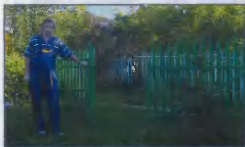
Открывающиеся внутрь ворота позволяют заехать на участок задним ходом «за один раз», без лишних маневров
