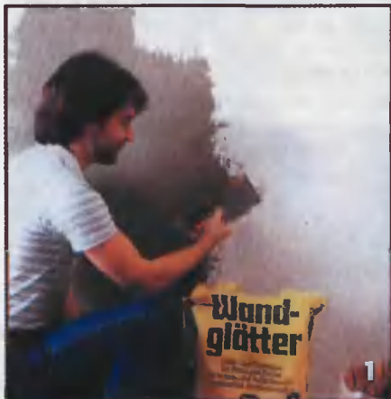
Раствор для выравнивания стен наносят на неоштукатуренную кладку (или потрескавшуюся штукатурку) тонким слоем и аккуратно разглаживают
