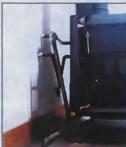
Солнечный коллектор над оранжереей работает параллельно с нагревателем воды в дровяной печке. Дрова и солнце — идеально дополняющие друг друга источники тепла. Когда нет солнца — разжигают печку
