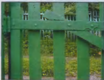
Петли для навеса секций ворот прикреплены болтами, а жесткость рамы каркаса ворот обеспечивается диагональным брусом
