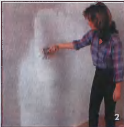
Когда штукатурка затвердеет, стену покрывают дисперсионной краской. Краске, стойкой к истиранию, следует предпочесть несмываемую
