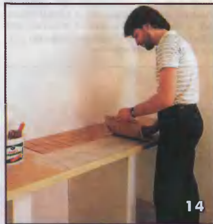
В дополнение к устроенным полкам монтируют рабочий стол, на который можно поставить сумки с купленными продуктами, прежде чем загрузить ими полки. Поверхность столешницы также облицовывают керамической плиткой
