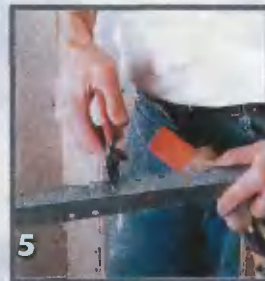
Старомодный способ. Надрезы на одной полке угловой металлической накладке позволяют согнуть ее по профилю арки
