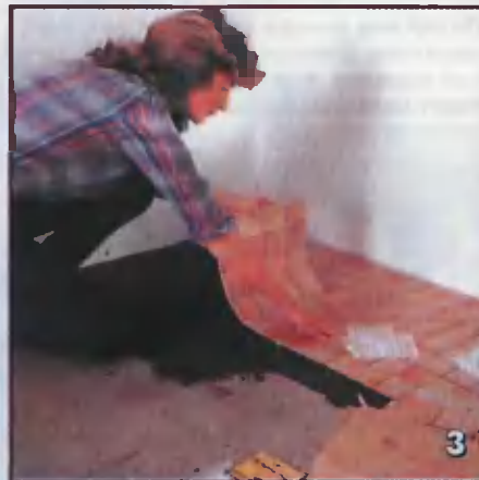
Мозаичную плитку можно укладывать сразу же после нанесения клея на сухую и очищенную от пыли цементную стяжку. Клей наносят зубчатой кельмой
