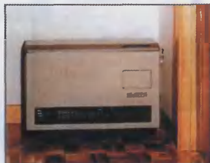
Система обогрева дома имеет еще один источник тепла — газовый нагреватель мощностью 3,6 кВт. Для обычного дома этой мощности совершенно недостаточно, но для сверхтеплоизолированного и герметичного дома, использующего еще и солнечное тепло, этой мощности хватает
