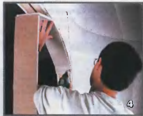
Гибкая, но непрочная. Благодаря надрезам обычная сухая штукатурка становится очень «популярной». Однако работать с ней нужно очень осторожно
