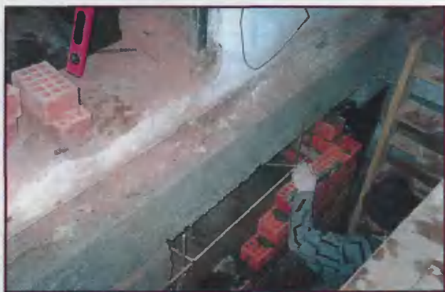
В несущей стене проделали проем, который укрепили стальными уголками и швеллерами. Часть фундамента камина обращена в погреб, поэтому опалубку выложили из лицевого кирпича. Справа видна лестница в погреб
