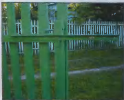
Такой запор для ворот обеспечивает параллельность плоскости их створок
