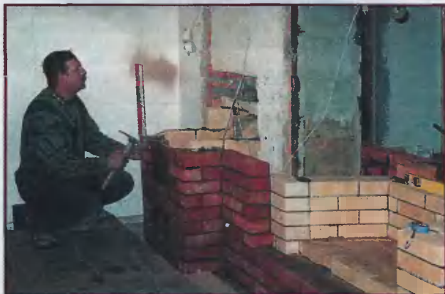
Кирпич ручной формовки имеет невысокую прочность на сжатие, но термостойкость его вне всяких сомнений. Форма кирпичей — не идеальная, поэтому проверяли вертикальность и горизонтальность каждого из них.
